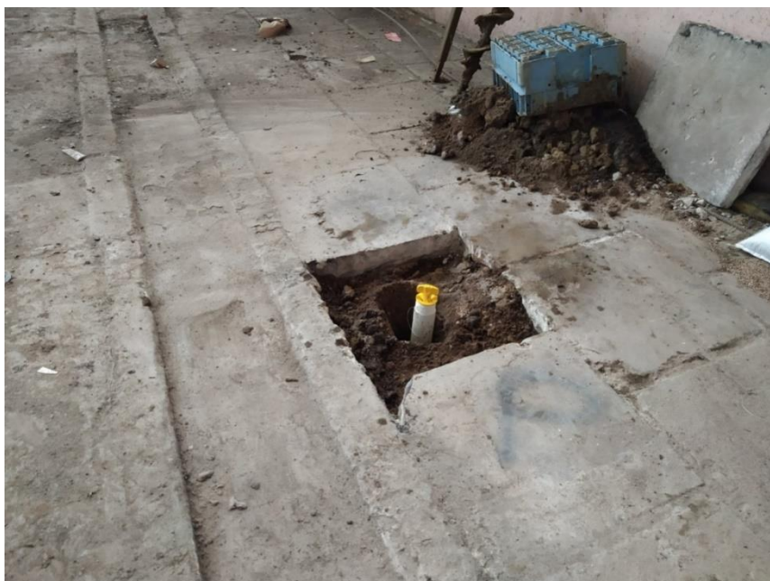
Figura 13. Instalação dos poços de monitoramento (configuração final dos poços).
