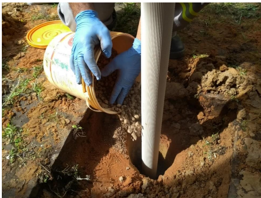
Figura 12. Instalação dos poços de monitoramento (colocação de bentonita).
