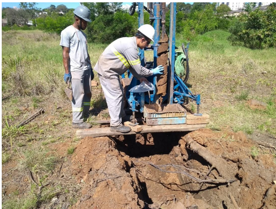
Figura 7. Aspectos gerais da metodologia de sondagem utilizada na área externa do empreendimento.
