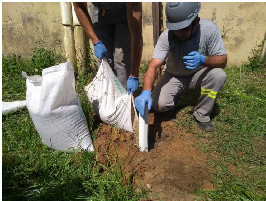
Figura 12. Instalação dos poços de monitoramento (colocação de bentonita).
