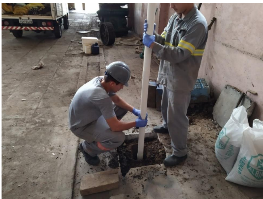
Figura 10. Instalação dos poços de monitoramento (colocação de revestimentos).
